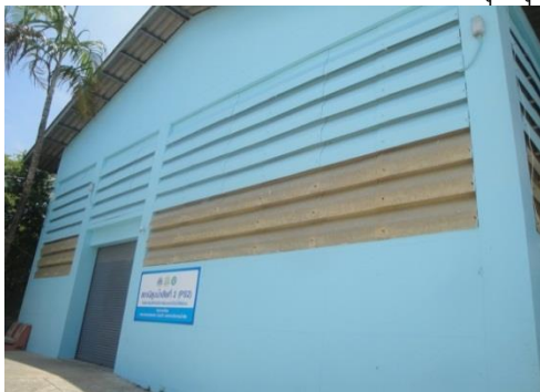
สถานีสูบน้ำเสียที่ 2 (PS2)
