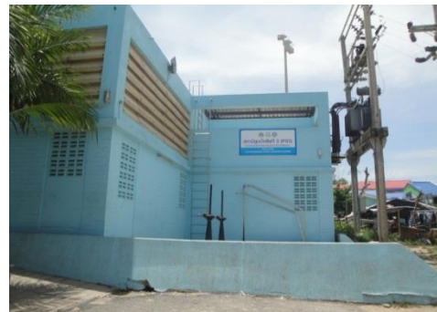
สถานีสูบน้ำเสียที่ 3 (PS3)
